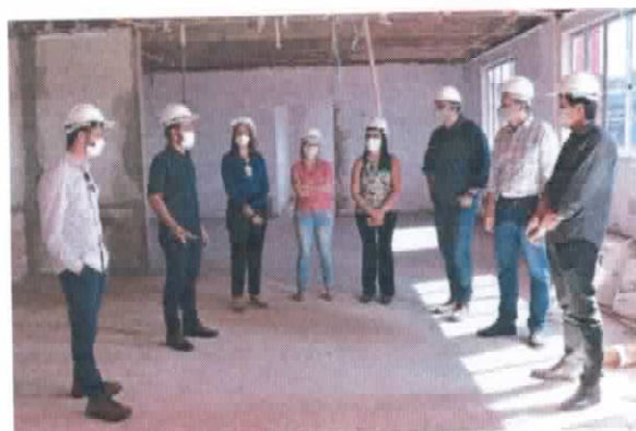
Hemocentro Coordenador finaliza primeira etapa da obra de reforma e ampliação
